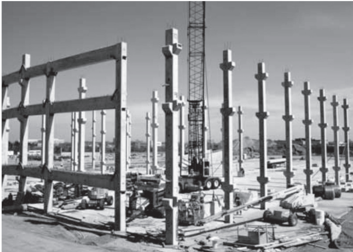
تصویر ۶-۳۷- احداث سازه پارکینگ با بتن پیش‌ساخته
