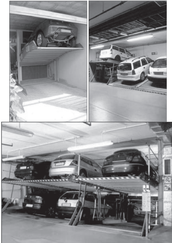
تصویر ۷-۱۳- پارکینگ های مکانیکی وابسته به خودرو (Pech et al, 2009: 197)
