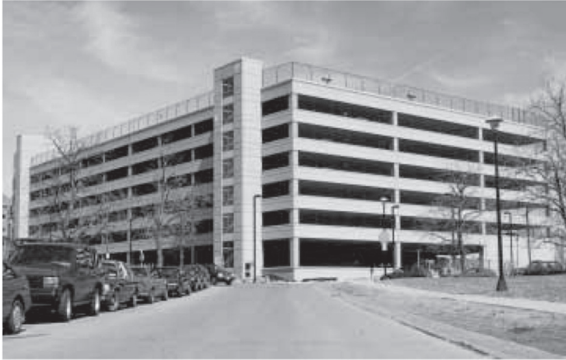
تصویر ۵-۲۵- پارکینگ طبقاتی مرکز پزشکی شهر آلبانی در ایالت نیویورک امریکا (Force, 1997: 1-4)
