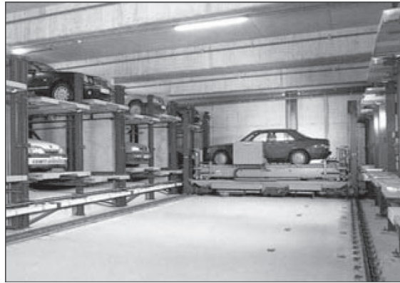
تصویر ۳-۷- پارکینگ مکانیکی با باربر متحرک افقی (Pech et al, 2009: 199)
